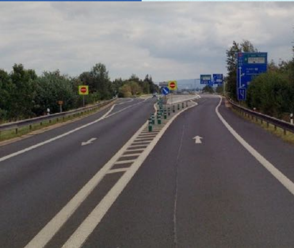
Stav po 2. úpravě
