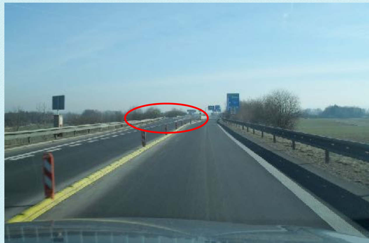
Stav po 1. úpravě
